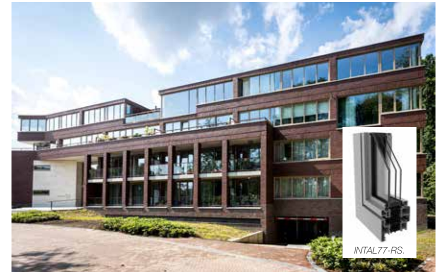
In het gehele project zijn circulaire aluminium kozijnen en vliesgevels van Intal toegepast om aan de hoge isolatiewaarden te voldoen. (Beeld: Sebastiaan Rozendaal)
