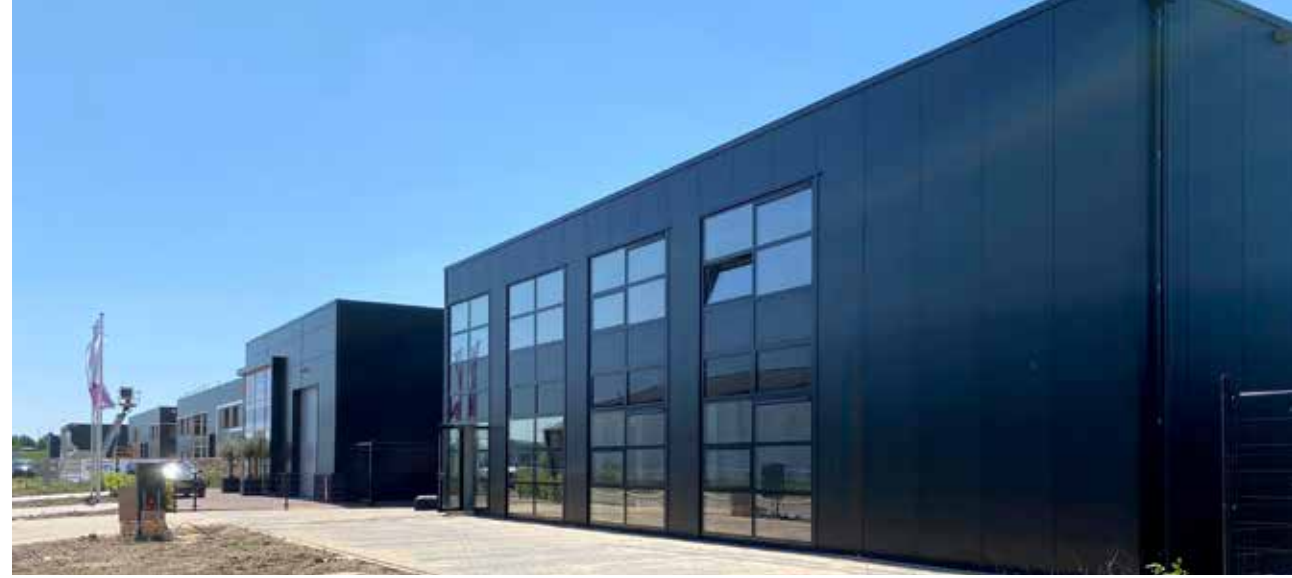
Een bedrijfsgebouw dat Intal samen met Hardeman gerealiseerd heeft, waarbij de samenwerking uitermate soepel is verlopen.
