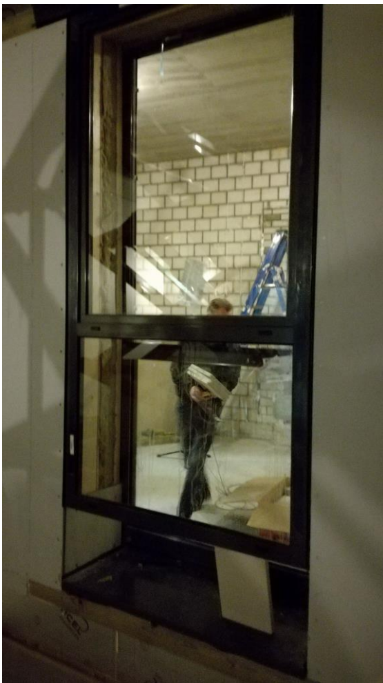
Kozijn buitengevel (meetkamer 3)
