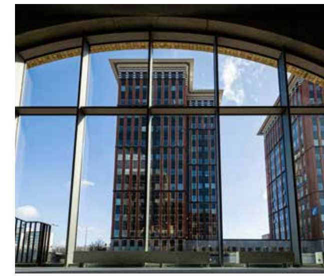
Intal produceerde en monteerde de getoogde vliesgevels met enorme overspanningen in meerdere afmetingen en radii.
