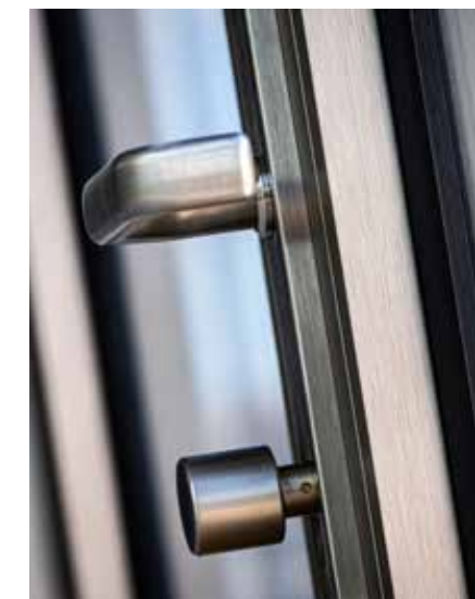
De toegepaste aluminium Intal profielen zijn geborsteld en geanodiseerd.
